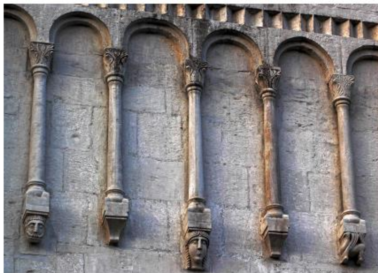
Аркатурно-колончатый пояс на фасаде
